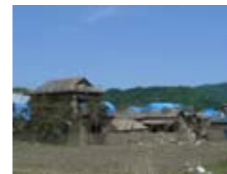
写真13 北条地区の被害状況
