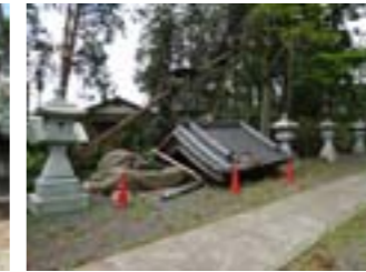
写真2 拝殿・本殿は無被害
