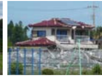
写真5 在来木造建物の被害②
