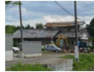
写真4 在来木造建物の被害①
