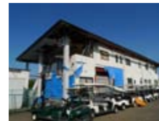
写真7 クラブハウスの被害
