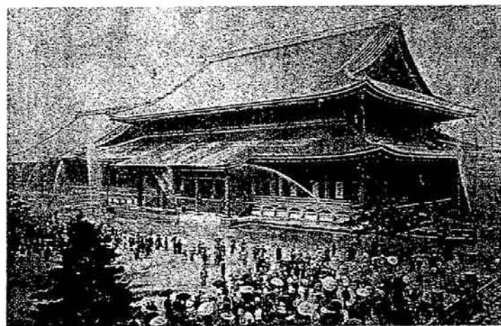
完成した本願寺水道を使って行われた「噴水防火大試験」（1897年8月、東本願寺提供）
