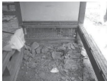
(b) 床下に壁土なし 写真2 土壁の施工状況
